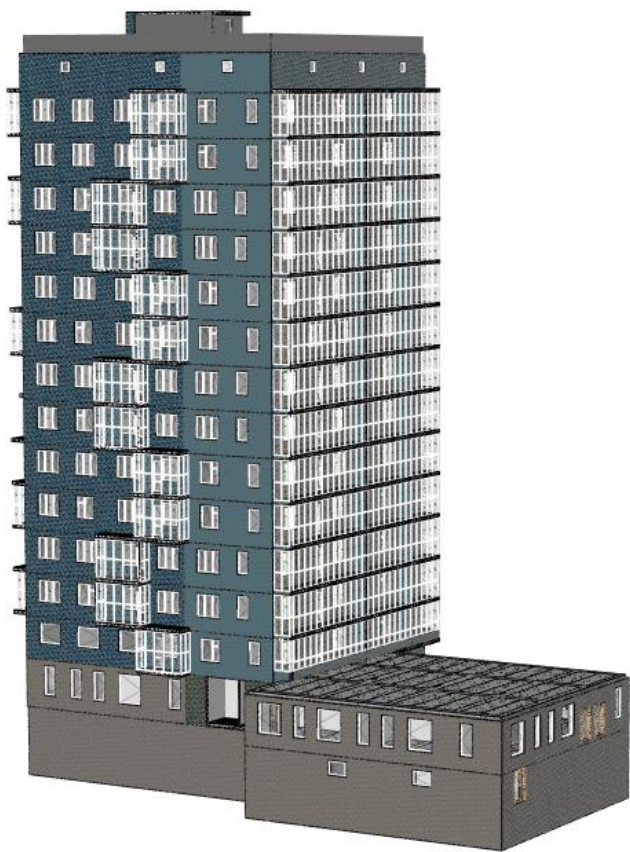
Многоквартирный жилой дом Республика Саха, Якутск
